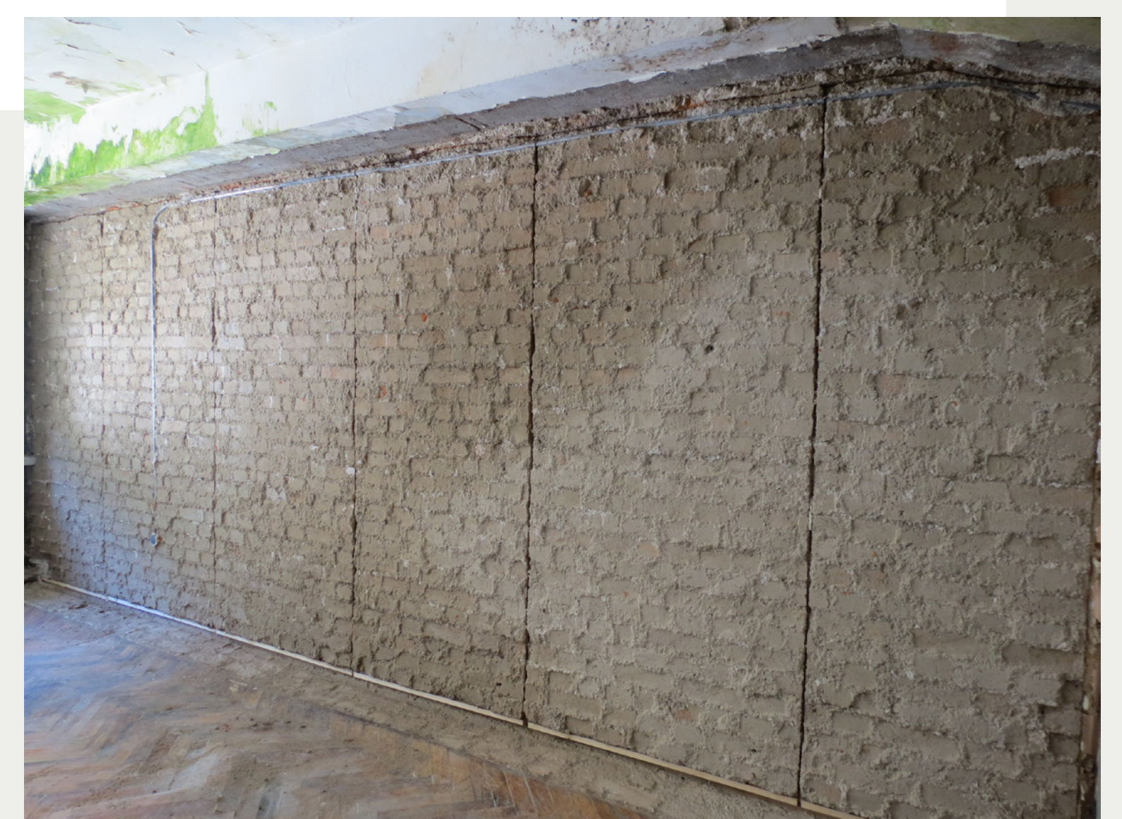
Slika 6: Stanjšana in razrezana hrbtna stran (foto Martina Lesar Kikelj)
