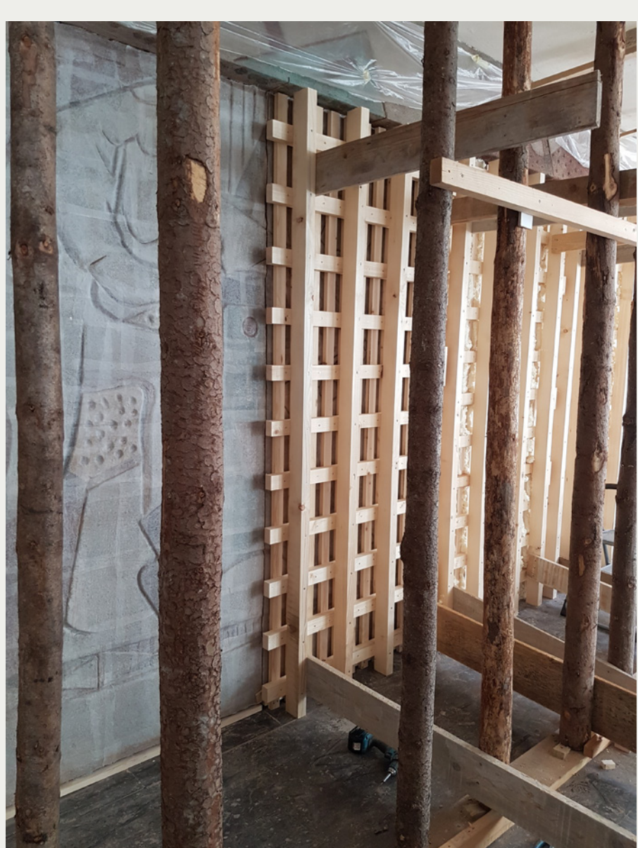
Slika 7: Dodatna zaščita z leseno mrežno konstrukcijo (foto Martina Lesar Kikelj)
