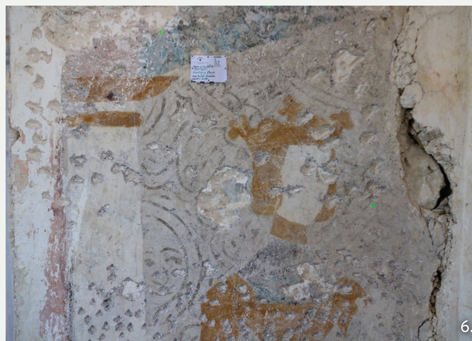
Slika 6, 7: Poslikava na slavoločni steni cerkve sv. Jošta v Šentjoštu, pred posegom in po kitanju z malto v barvi intonaca. (foto Ajda Mladenović)
