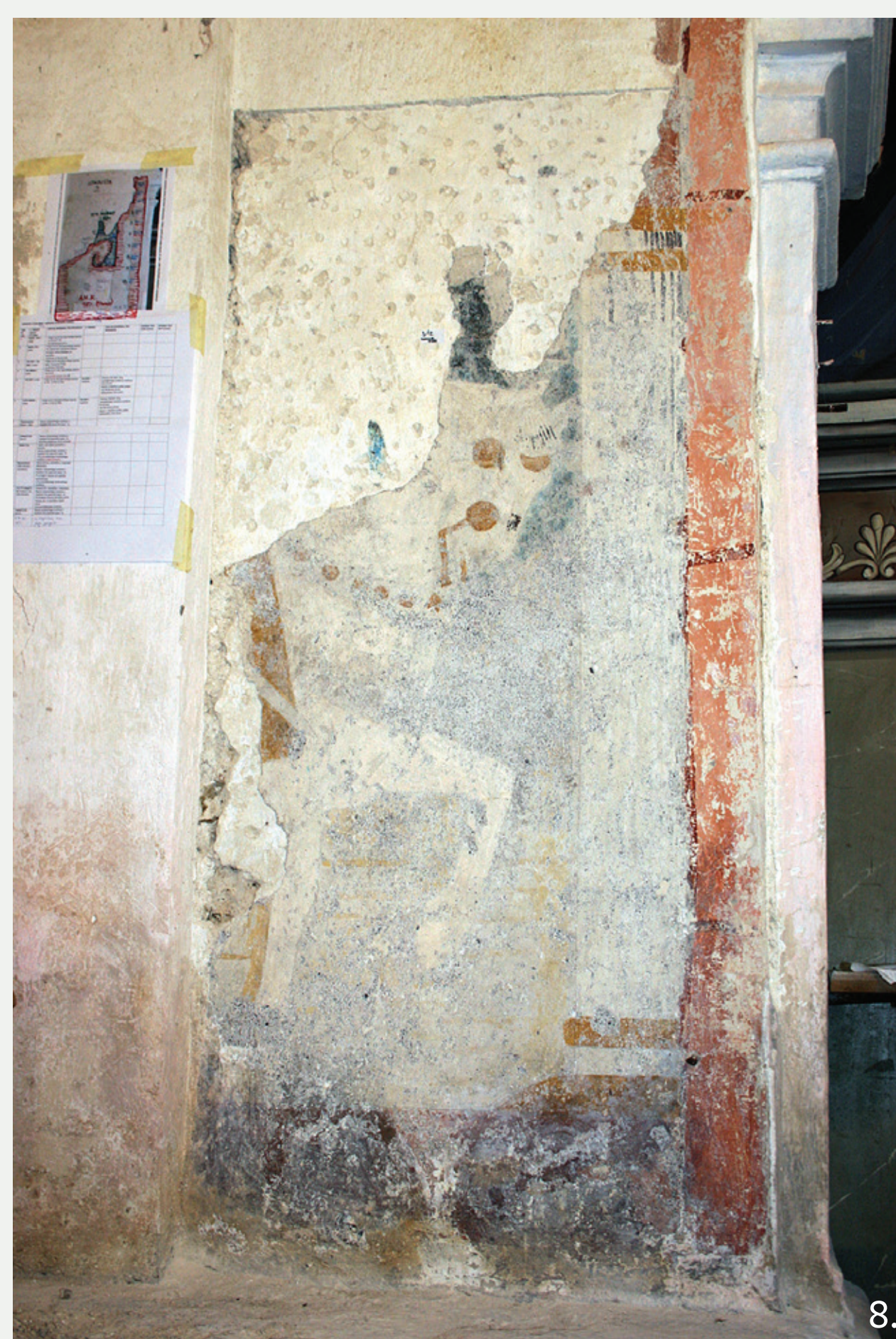
Slika 6, 7: Poslikava na slavoločni steni cerkve sv. Jošta v Šentjoštu, pred posegom in po kitanju z malto v barvi intonaca. (foto Ajda Mladenović)
