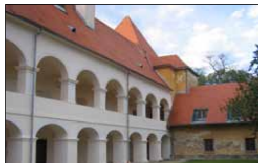
Obnovljeni obočni del fasade gradu Rakičan
