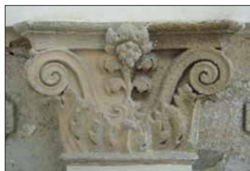
Detajl fasade, mehansko čiščenje
