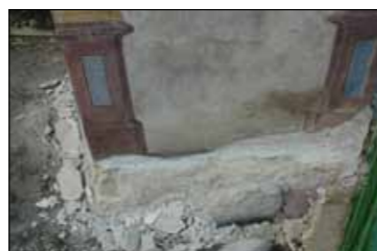
Februar 2011, odpadli cokel in del poslikave
