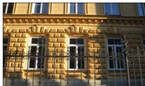
Z mineralnimi materiali obnovljena in hidrofobirana fasada Pravne fakultete v Mariboru
