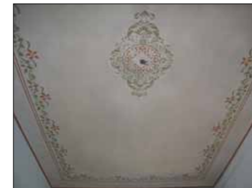
Strop po posegu
