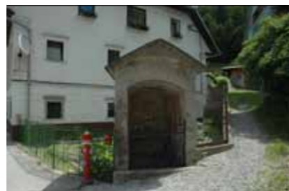
Junij 2010, pred obnovo
