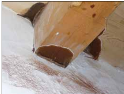
Zaradi neustrezno izvedene rekonstrukcije se je po nekaj mesecih v obnovljenih prostorih Žičke kartuzije pojavila siva hišna goba ( Serpula lacrymans ). Rjavo barvo stene so povzročili trosi, ki so nastali na rjavkastem trosišču sive hišne gobe (foto: Franc Pohleven)
