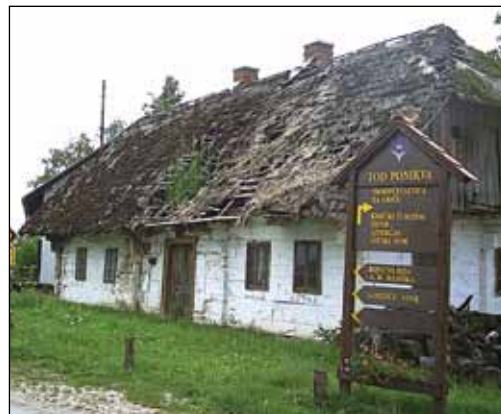
Več kot sto let stara lesena hišica na Ponikvi se je zaradi neobnavljanja (zamakanja) kritine v nekaj mesecih porušila, z njo je propadel tudi del tehnične in kulturne dediščine tega kraja (foto: Franc Pohleven)
