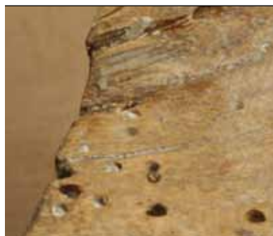
Ukleščena silikonska guma v manjši razpoki nosilca
