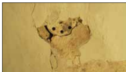
Delno odkrita perforirana površina
