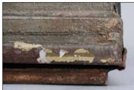
Poškodovani detajl ptičje hišice
