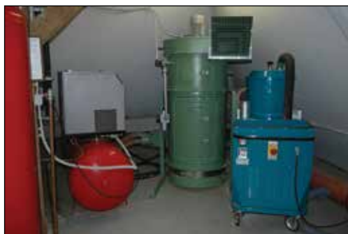
Sesalci in kompresor v strojnici
