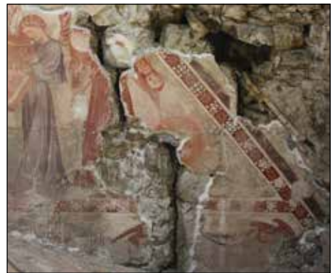
Detajl po odstranjevanju plomb, ometov in nestabilne pozidave
