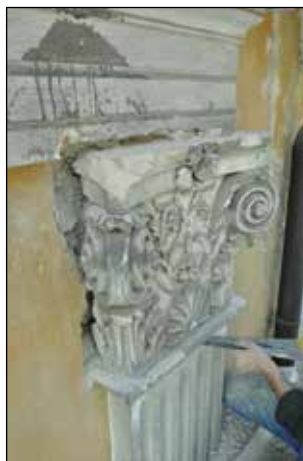
Odstranjevanje slabih štukatur s fasade
