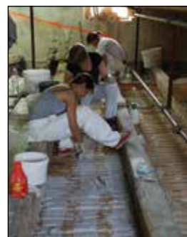
Vipava, Lanthierijeva graščina, strop salona. Utrjevalna dela na podstrešju. Nanos treh pasov mreže in fine apnene malte, med njimi pa nizko ekspanzijske poliuretanske pene
