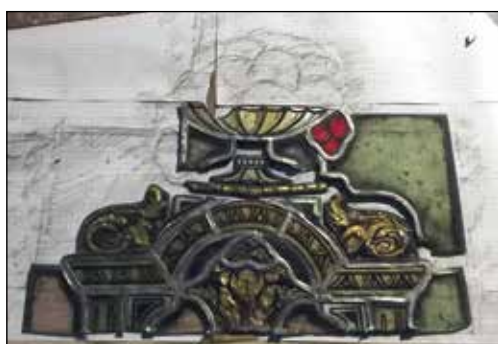
Odprt svinčeni nosilec med restavriranjem
