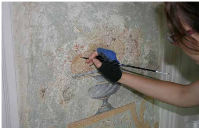
Slika 5 Retuširanje poslikave in situ v dekorativnih kasetah na steni (foto: Anka Batič)
