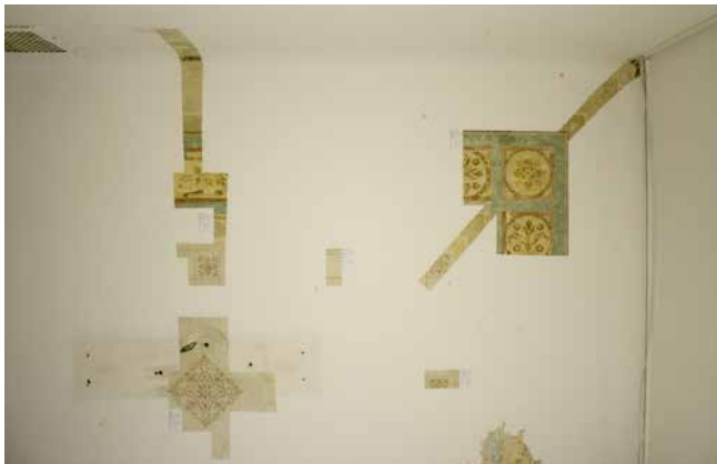
Slika 1 Sonde v medetažnem prostoru Narodnega doma (foto: Anka Batič)
