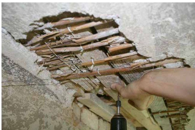
Slika 4 Dopolnjevanje originalnega nosilca stropne dekoracije (foto: Anka Batič)
