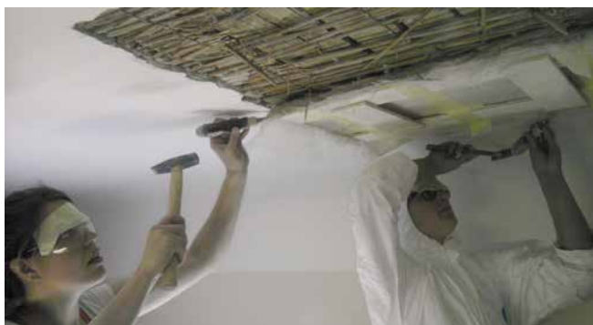
Slika 2 Snemanje dela obrobne pasu z originalnega nosilca (foto: Katja Pohl)
