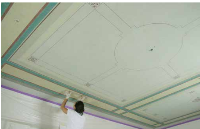
Slika 6 Med rekonstruiranjem obrobne pasu na novem stropu (foto: Anka Batič)
