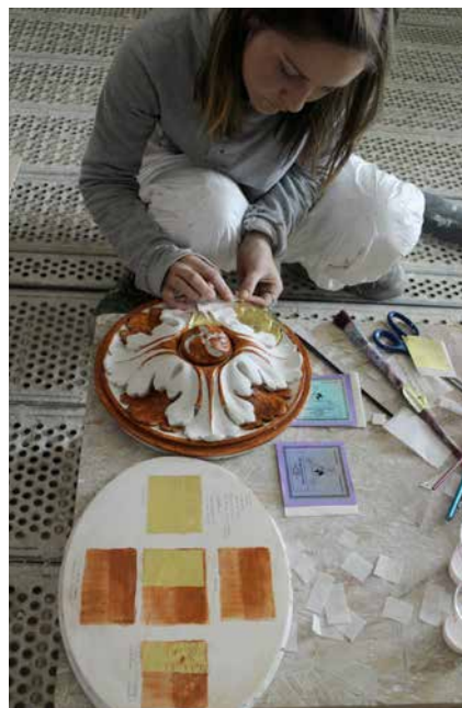
Slika 1 Na podlagi izvedenih sond je odgovorna konservatorica Marija Režek Kambič naredila več barvnih študij. Izdelali smo kopijo rozet in izvedli več poskusov prezentacije štukatur. (foto: arhiv ZVKDS RC)
