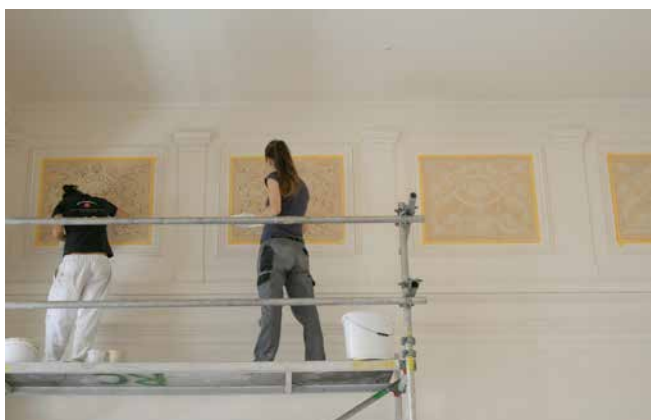
Slika 8 Med rekonstruiranjem poslikav v kasetah na steni (foto: Saša Snoj)
