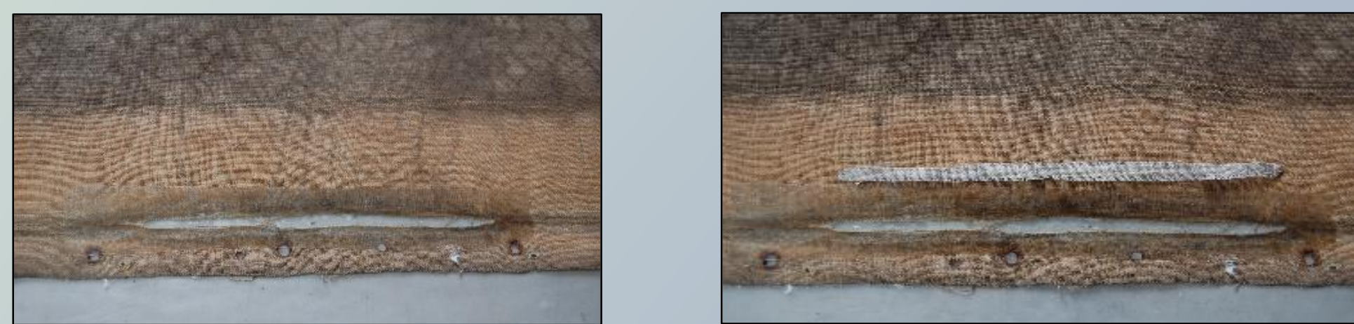
Kitanje poškodovanih delov
