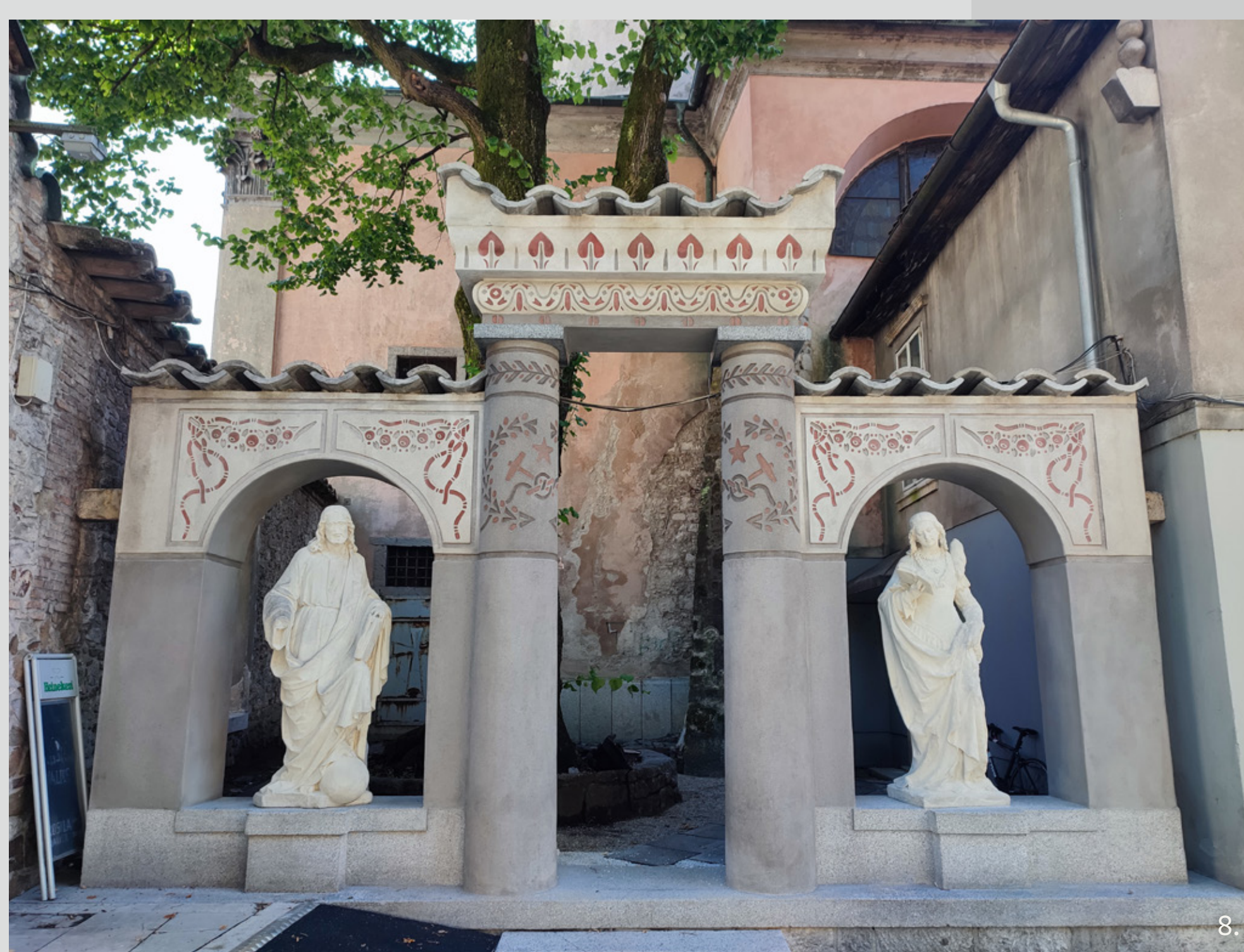
Slika 8: Slavolok v Križankah po končanih konservatorsko restavratorskih posegih. (foto: arhiv ZVKDS Restavratorski center, oddelek za kamen in štukaturo)
