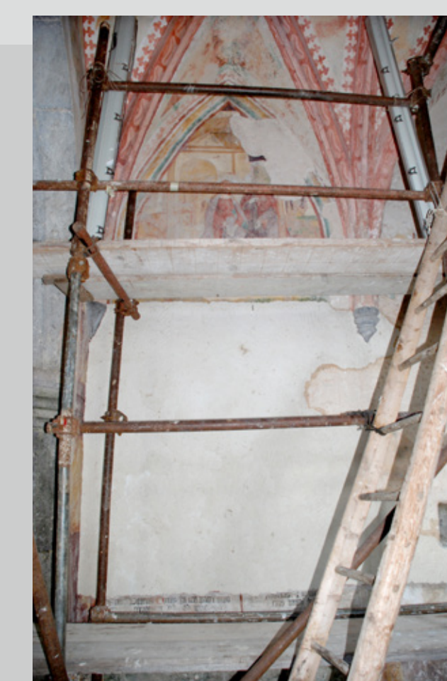
Slika 9: Utrjevanje poslikave s Calosilom. Vodne obloge po nanosu Calosila
