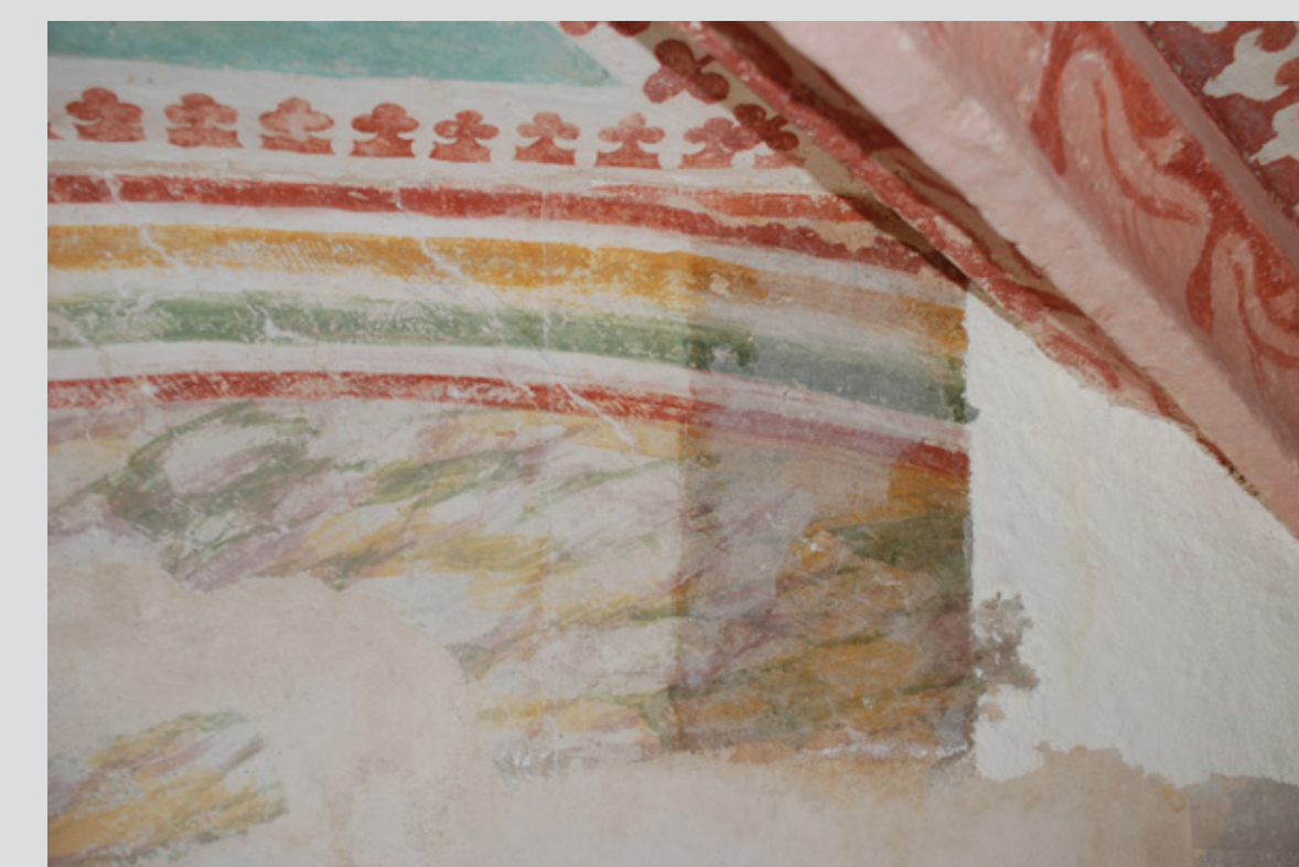
Sliki 6a, 6b: Poskusno utrjevanje na slavočni steni z barijevim hidroksidom, di-amonijevim fosfatom in Calosilom (Cal 1). Potemnitev poslikave, ki jo je povzročil di-amonijev fosfat je izginila šele po dobrem letu.
