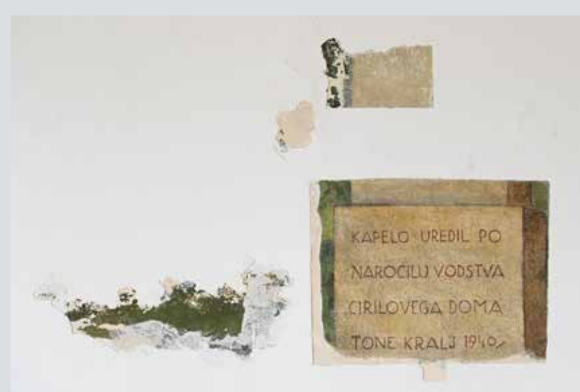
Slika 3. Odkrit in restavriran napis na južni steni učilnice, zraven odpadanje beležev in vidna poslikava spodaj (foto: R. Hafner)
