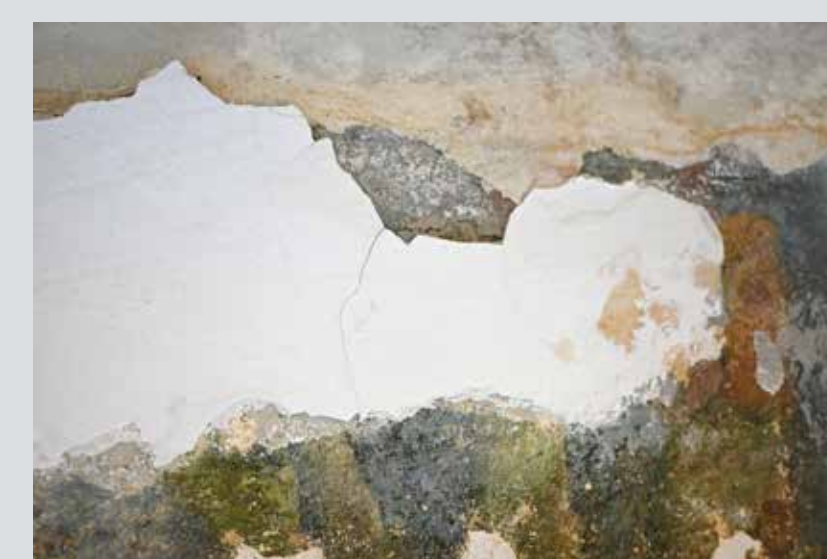
Slika 4. Med odstranjevanjem beležev, zamakanje poslikave (foto: A. Batič)
