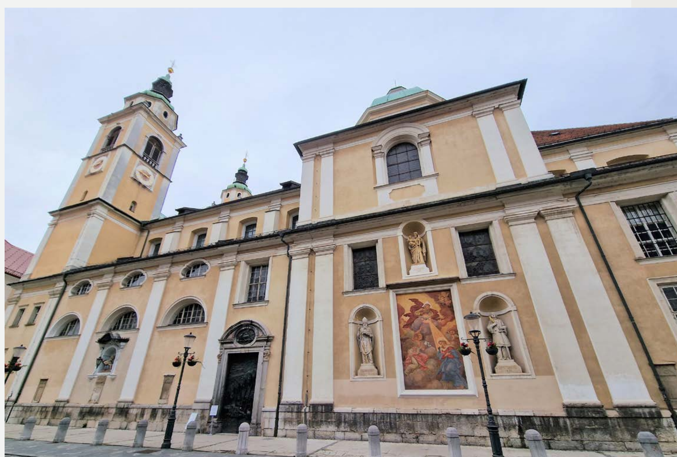
Slika 7: Južna fasada stolne cerkve sv. Nikolaja s kipom sv. Jožefa po končanem konservatorsko restavratorskem posegu. (foto: arhiv ZVKDS RC, Oddelek za kamen in štukaturo)
