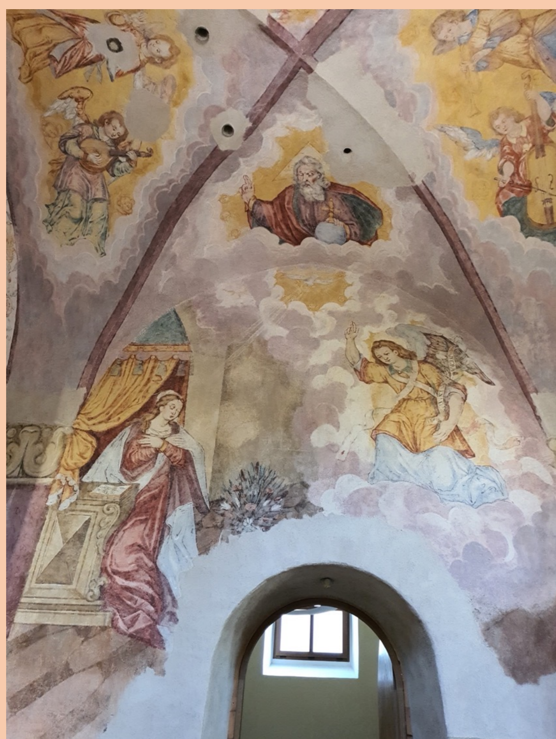
Pogled na poslikavo po zaključenih posegih.
