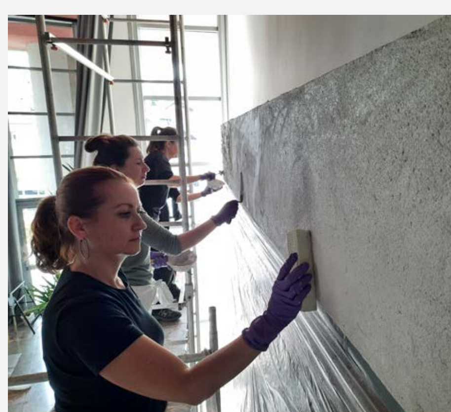
Slika 9: Nanos in oblikovanje dekorativnega ometa za rekonstrukcijo zgornjega dela zgrafita.
