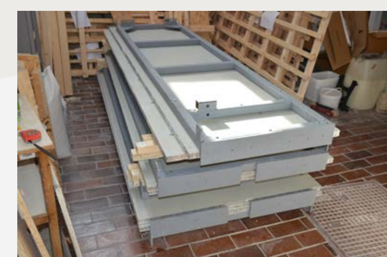
Slika 4: Zadnja stran nosilca z jekleno konstrukcijo.
