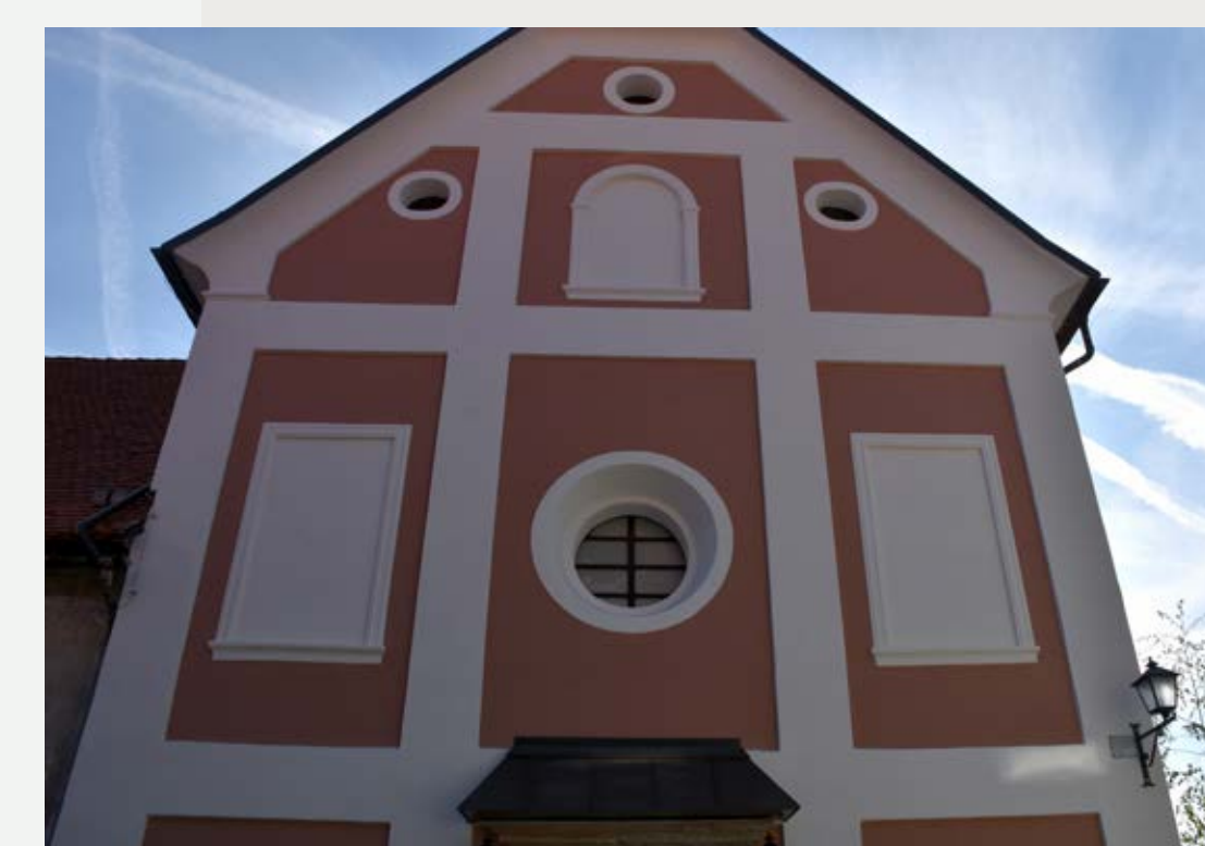
Fasada cerkve Žalostne Matere božje po končani obnovi.
