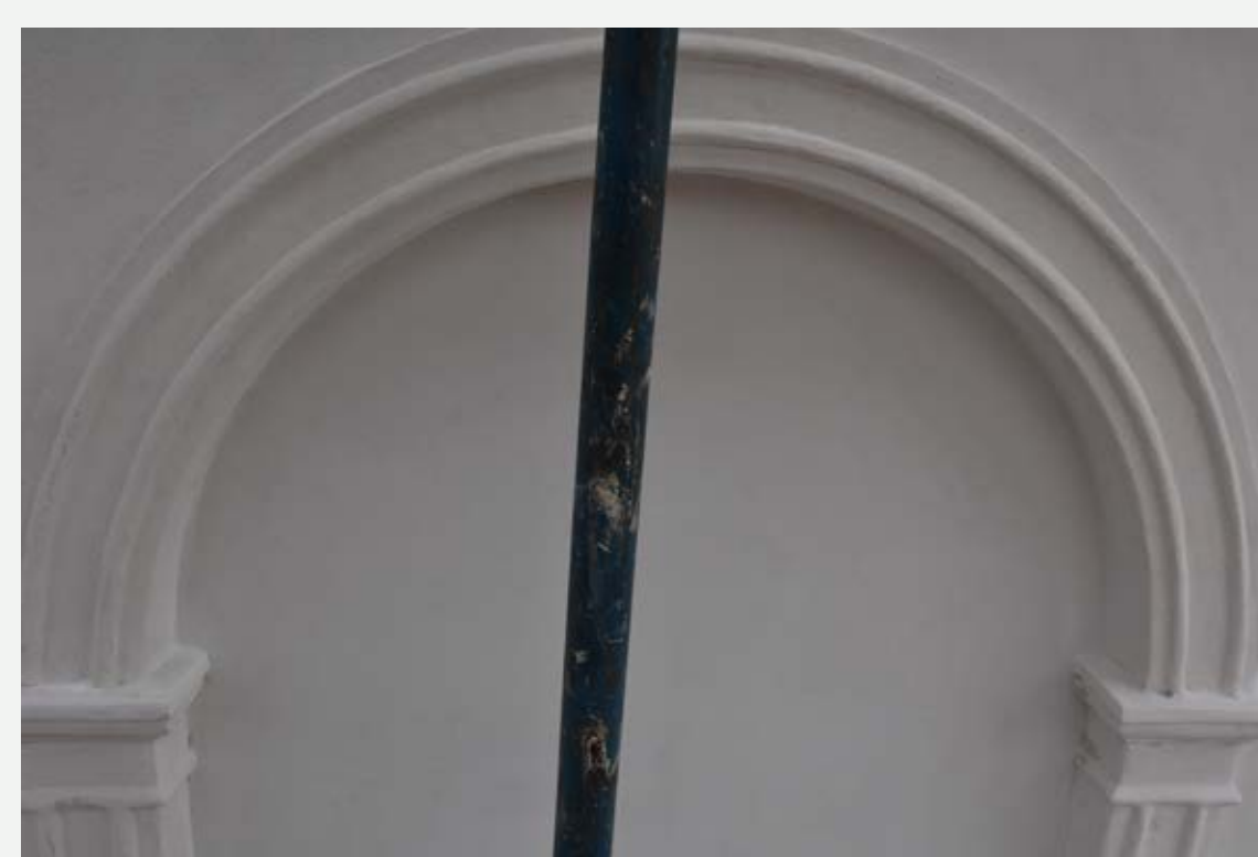
Površina novega nosilca obdelana z ometom.
