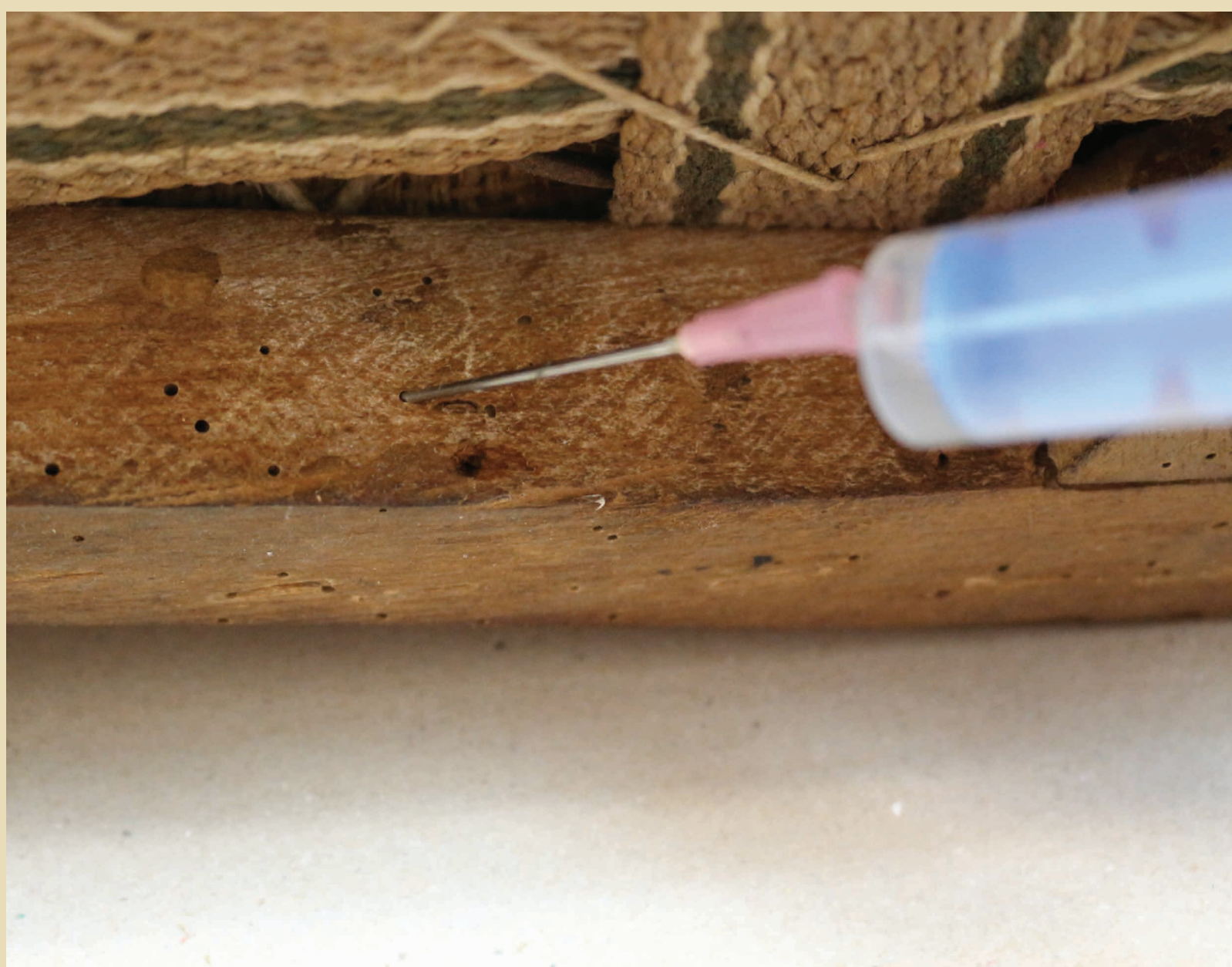
Injektiranje biocida v izletne luknjice in-
