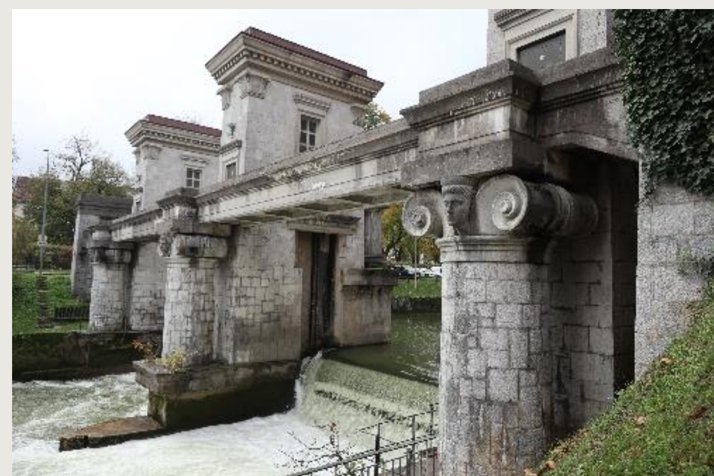
Slika 1: Vodna zapornica na Ljubljani
