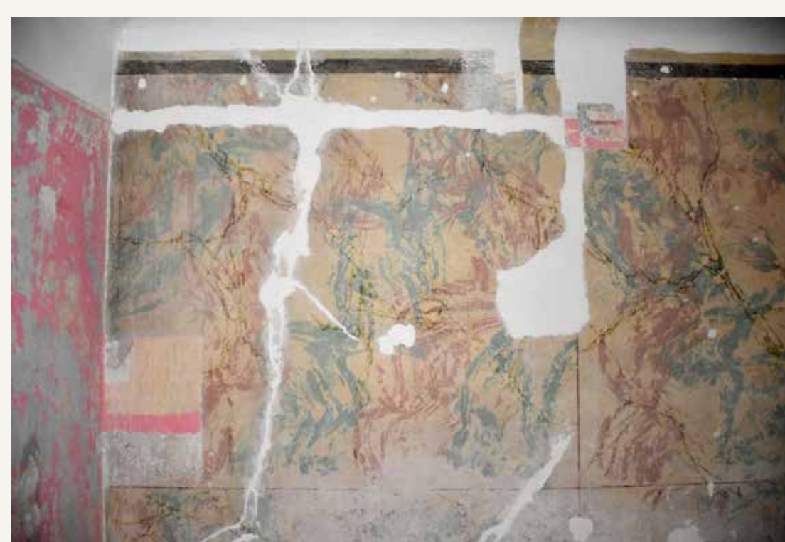
Del stenske poslikave po končanem kitanju poškodb.
