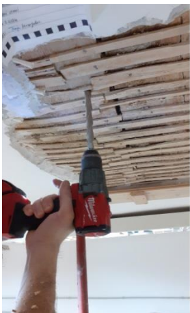
Slika 13: Odvzem vzorca iz lesene konstrukcije stropa za identifikacijo lesne vrste (foto: Luka Krže)
