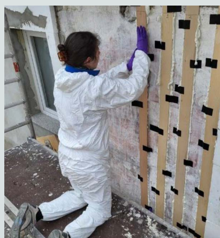
Med izdelavočasne opore pred snemanjem.
