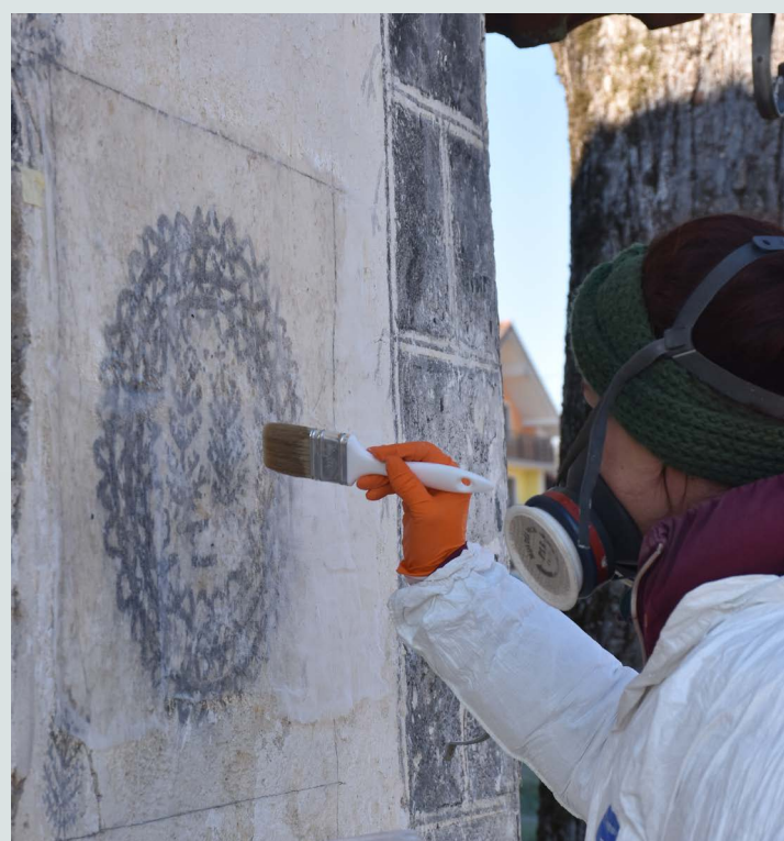
Stenska poslikava med izdelavočasne zaščite z gazo in lepilom.
